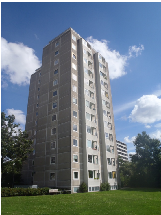
Foto 1. Nord- og vestvendt facade på bygning 24A/B og 26
