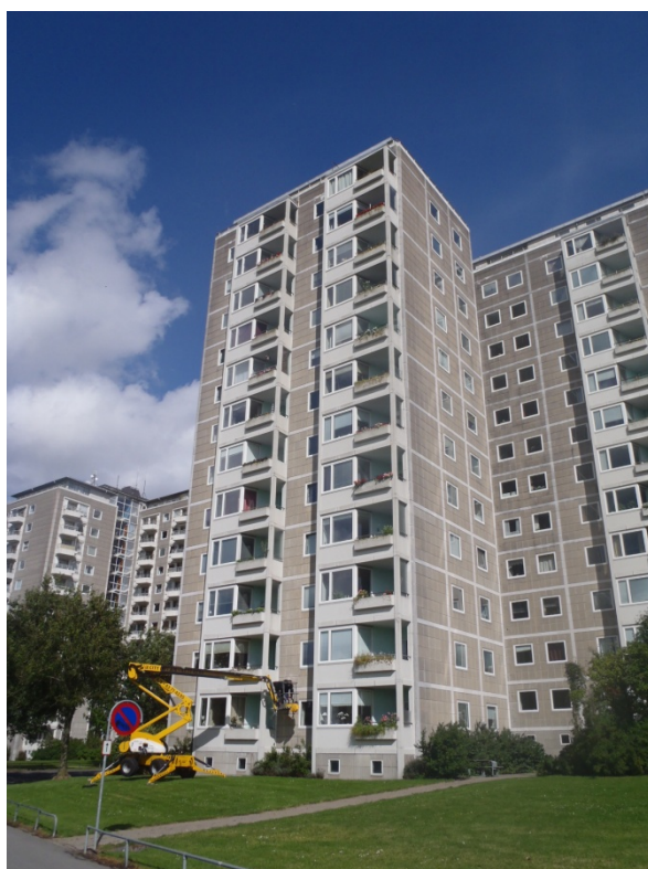
Foto 1. Vestvendt facade på undersøgte bygning opgang, 17B
