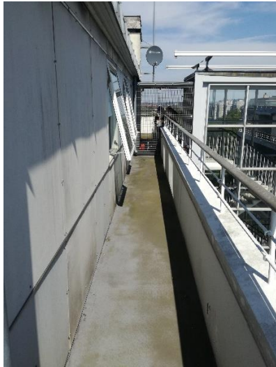
Eksisterende forhold med støbeasfalt Principsnit fremtidig opbygning
